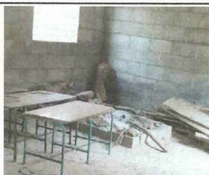
Foto 3: Mejoramiento de Polletón en la cocina
