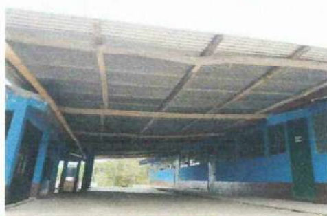
Foto 5: Mejoramiento de techo de patio entre aulas
