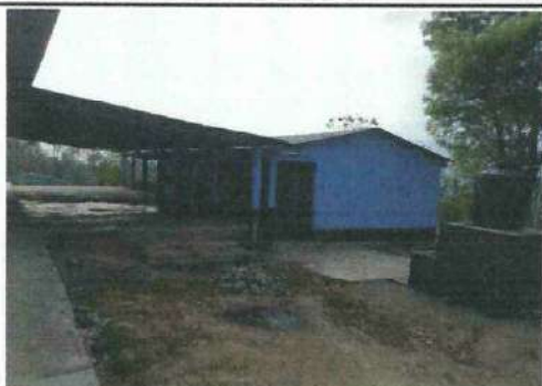
Foto1: Mejoramiento y Ampliación de Piso de Patio entre aulas
