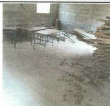
Foto 2: Mejoramiento de Piso en la Cocina
