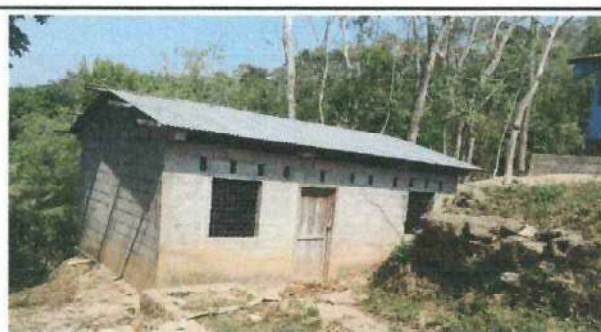
Foto 4: Cernido en paredes de la cocina
